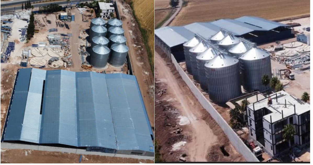
İnşaatın Rapor Tarihindeki Hali
