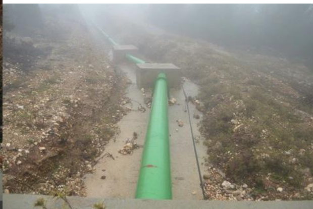
TAŞMA TAHLİYE KANALI 700 mm. CEBRİ BORU III.ÇUKURÇAY HES SANTRAL BİNASI
