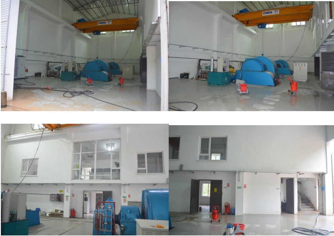
Santral Binası Türbinlerin bulunduğu bölümden görünüm
