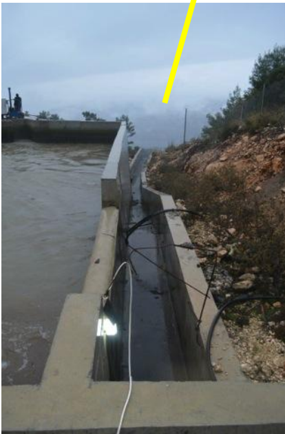
TAŞMA TAHLİYE KANALI 700 mm. CEBRİ BORU III.ÇUKURÇAY HES SANTRAL BİNASI
