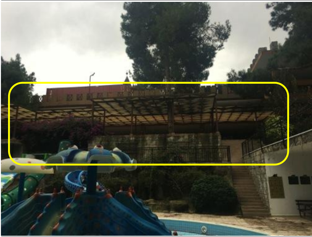
Bu ünite Aqua park kısmına hizmet amaçlı inşa edilmiştir. Projesine göre; 2 bodrum + zemin katlıdır.
