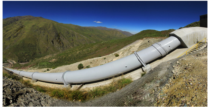
Çukurçay HES Cebri Boru Hattı
