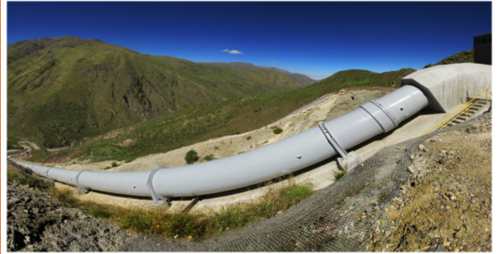
Çukurçay HES Cebri Boru Hattı
