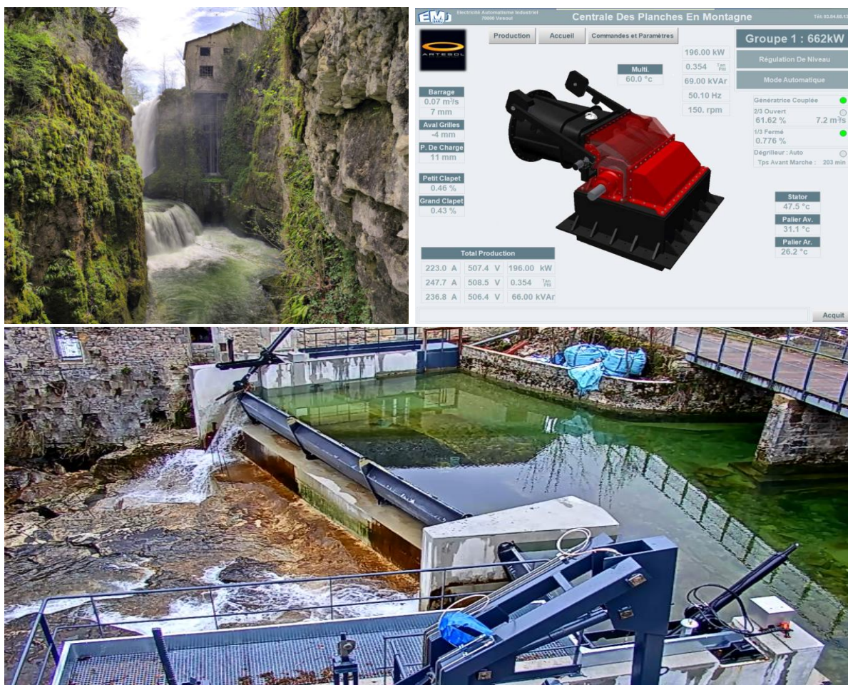
Photographies des Planches-en-Montagne (cascade, supervision, barrage & vannes clapets)
