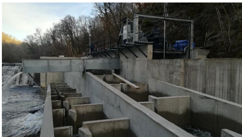
Photographie d'une passe à poisson en rive droite
