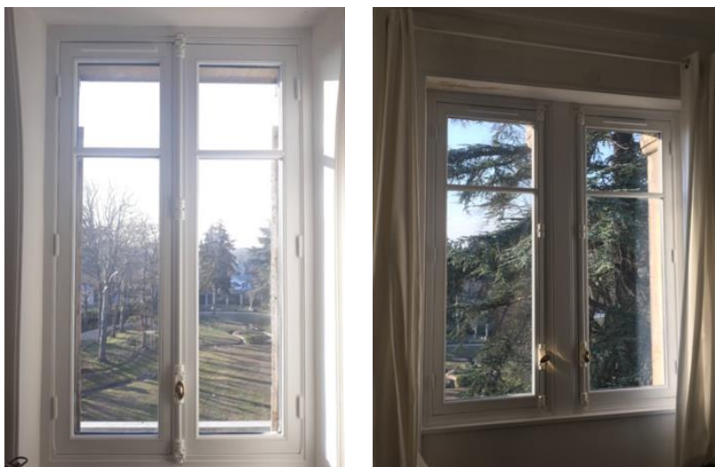
Photographies des nouvelles fenêtres double vitrage au second étage
