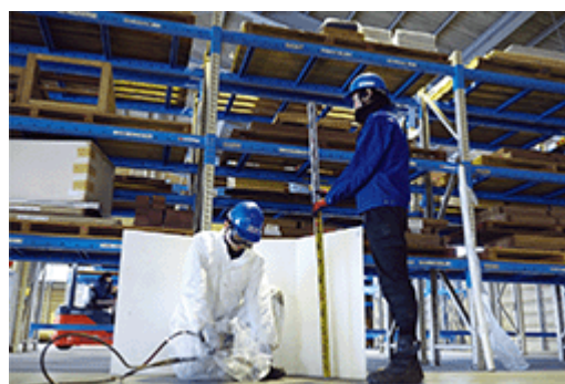
ミリ単位で常時レベル確認をしながら制度の高い施工を行う
