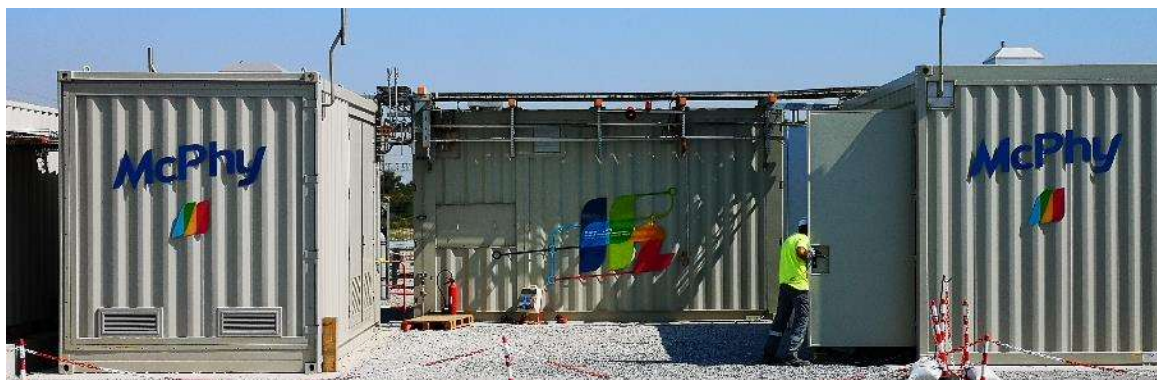
Jupiter 1000 : 1 MW d'électrolyse pour un démonstrateur PtG à Fos Sur Mer (0,5 MW alcalin + 0,5 MW PEM)
