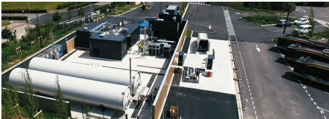
Haut de France, projet « SMT-AG » : première station hydrogène zéro-carbone pour bus en France (200 kg d'hydrogène / jour, 0,5 MW d'électrolyse).
