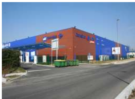
Bâtiment à usage de commerces et de loisirs, Ste Geneviève des Bois (91)
