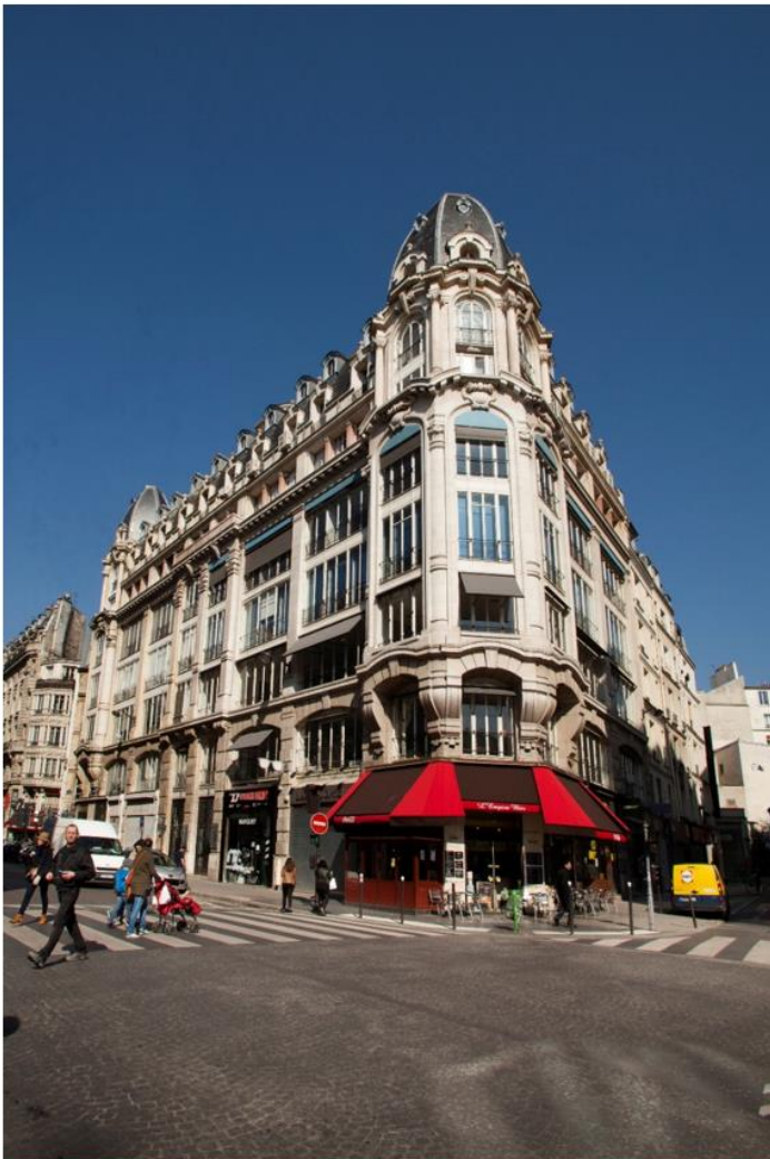
Rue Réaumur – Paris (2 e )
