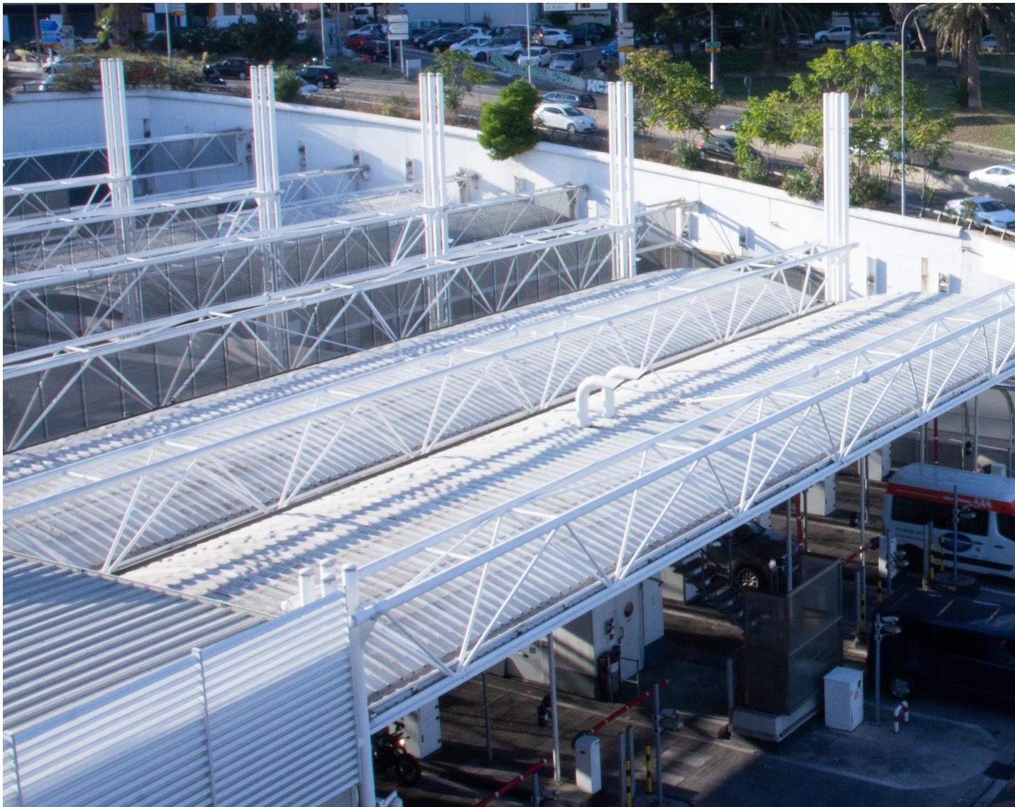
Depuis l'ouverture du tunnel Prado Sud, 4 plateformes de péage sont exploitées. Les 2 plateformes du tunnel Prado Carénage comprennent 6 voies chacune et les 2 du tunnel Prado Sud possèdent 5 voies chacune.
