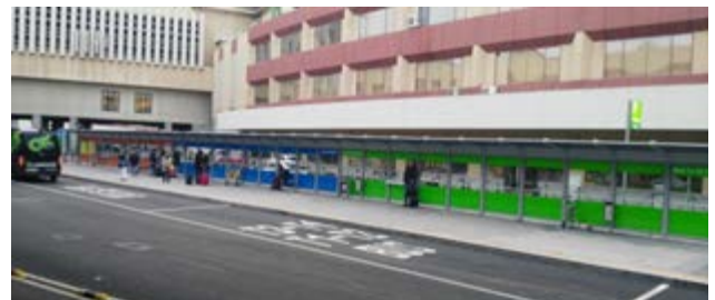
Imagen 15. Viales acceso. Aeropuerto A.S. Madrid-Barajas
