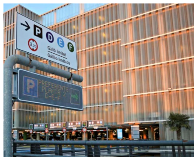
Imagen 28. Aparcamiento. Aeropuerto de Barcelona-El Prat
