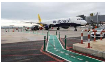
Imagen 17. Adecuación senda peatonal. Aeropuerto Alicante-Elche
