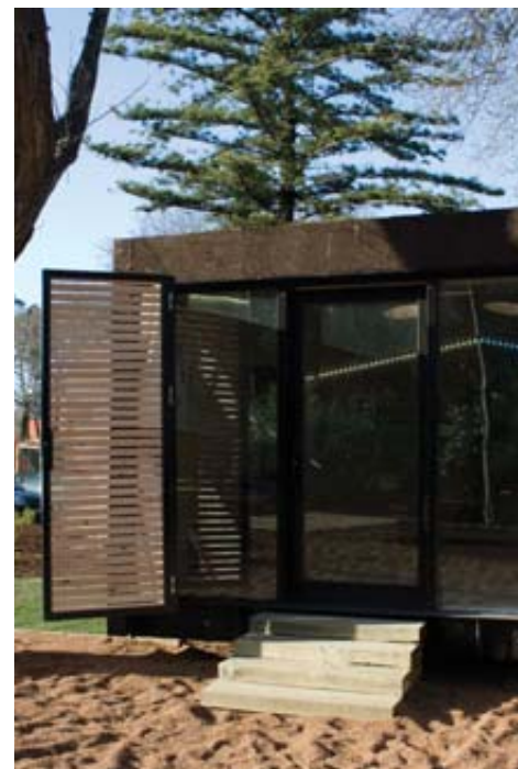
A Amorim Isolamentos apresentou o projecto Ecocabana, um novo conceito de alojamento destinado ao turismo ecológico, cuja principal novidade é o facto de ser totalmente revestida e isolada com cortiça.
