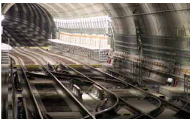
53 Metropolitano de Lisboa / Instalação de Via Betonada (Via Férrea e Carril de Energia)
