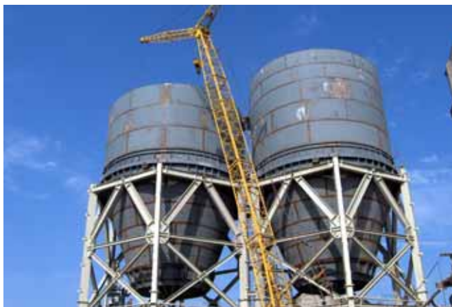
82 Fábrica CEMENT / Silos do Moinho de Clínquer
