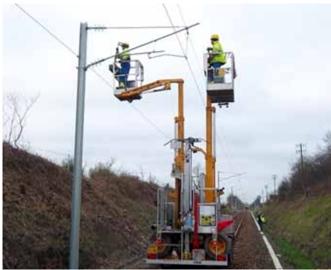
75 Electrificação de Via entre Nantes e Les Sables d'Orlone
