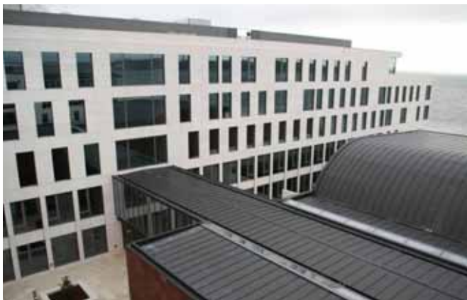
91 Edifícios para a Administração do Porto de Lisboa, no Cais do Sodré
