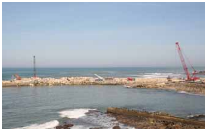
55 IPTM - Instituto Portuário e dos Transportes Marítimos / Reabilitação do Molhe Oeste do Porto de Peniche
