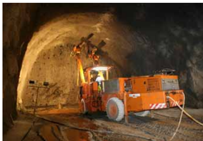
49 RAMEDM / Via Expresso Ribeira de S. Jorge - Arco de S. Jorge - 1ª Fase - Túneis
