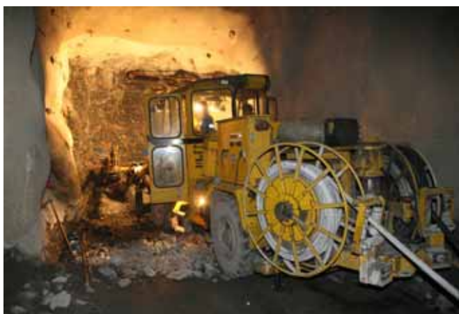
48 SOMINCOR / Execução de Túneis nas Minas de Neves Corvo
