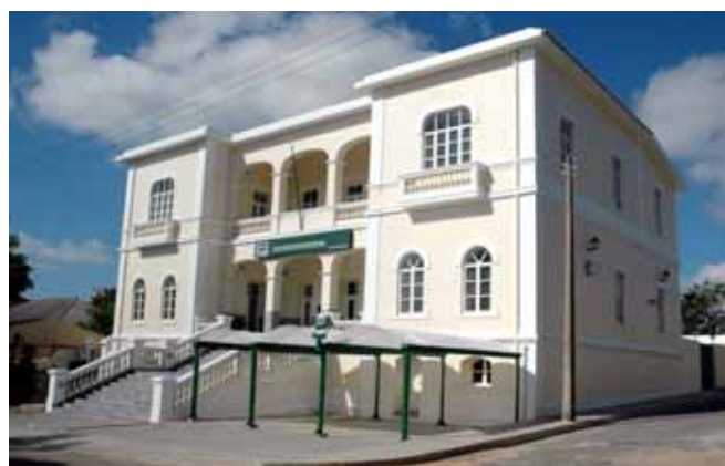
77 Telecomunicações de Moçambique / Reabilitação do Edifício Sede da DATI / Inhambane
