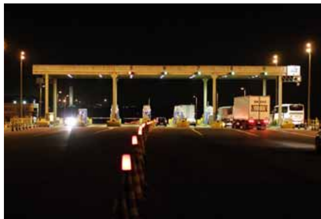
92 Concessionária de Rodovias TEBE / Trecho Rodoviário SP 326 / Bebedouro/Barretos / São Paulo / Brasil
