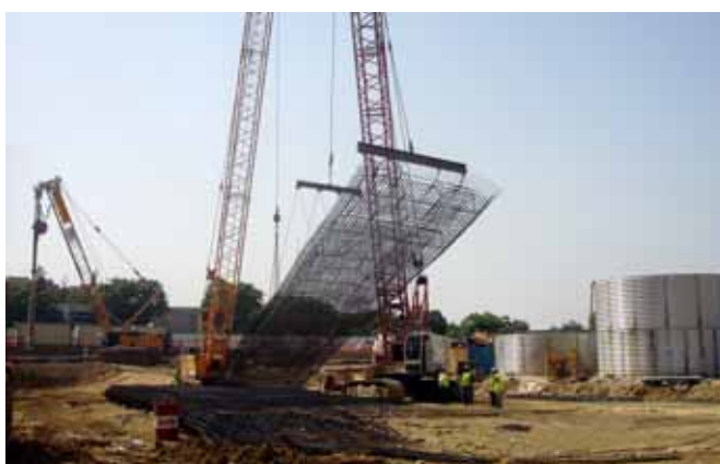
72 Sando / Parede Moldada e Estacas, no Intercambiador de Mairena de Aljaraje
