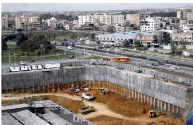
67 Contenção Periférica das Caves do Edifício Sede da Air Algerie
