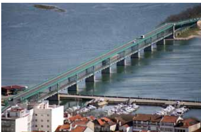
46 REFER / Reabilitação e Reforço das Infra-estruturas da Ponte Eiffel / Viana do Castelo
