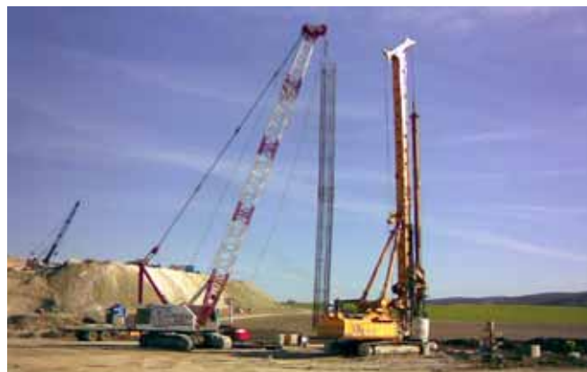
73 Ferroviál / Estacas e Jet-Mix, no viaduto La Motilla em Cuenca
