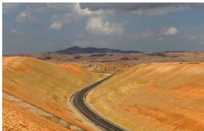
74 ONCF / Nova Via Férrea no troço Projectado entre Taourirt e Nador
