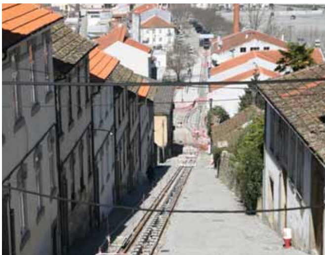
52 Liftech / Instalação da Via-Férrea para o Funicular de Viseu
