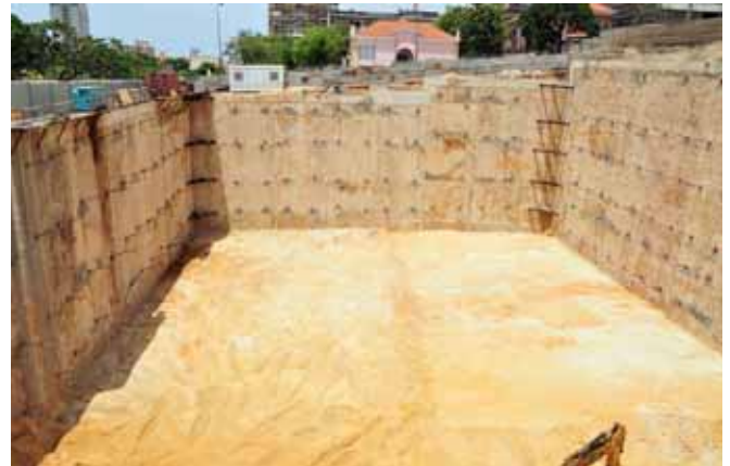
63 Paredes Moldadas e Escavação para Oito Caves no Edifício TORRES DO CARMO
