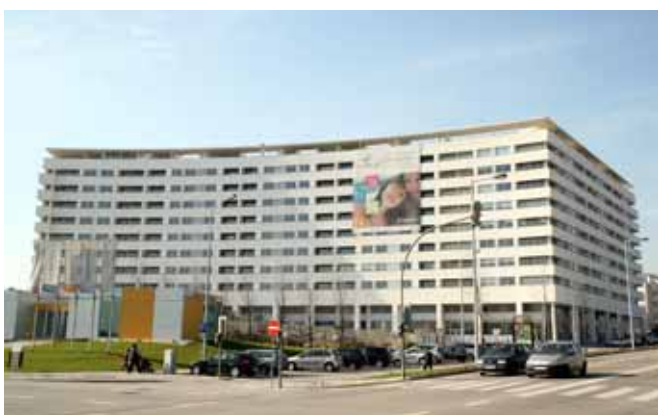
96 Empreendimento “Gaia Nova” / Edifício V10 / Vila Nova de Gaia
