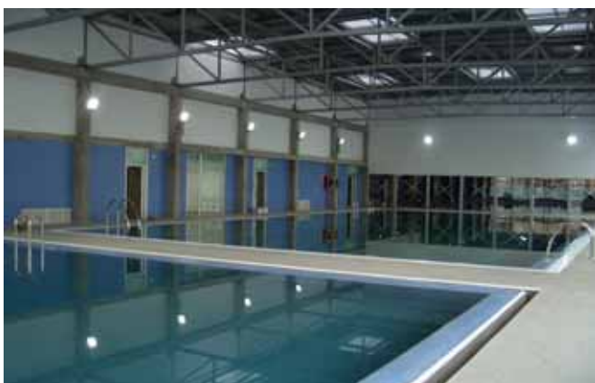
70 Piscina Coberta e SPA Municipais de Torrejon de La Calzada / Madrid
