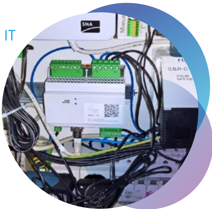
Oprema SUNSEED [WAMS PMC] na eni izmed lokacij Telekoma Slovenije
