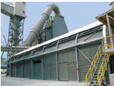
Neue Schalldämmung für die Rohmaterial-trocknung in Maastricht, Niederlande.
