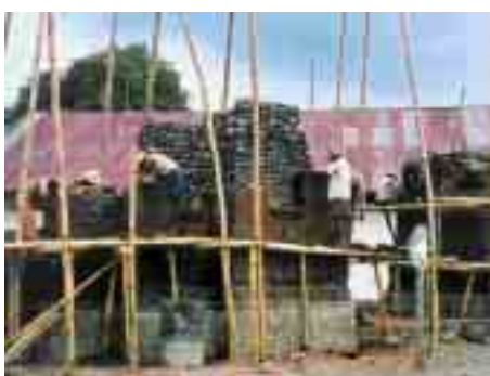
Baugerüste aus Bambus haben sich bewährt.
