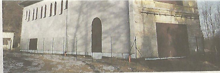
Z Kúpeľného domu sa podarilo zachrániť len vstupný portál (2).
