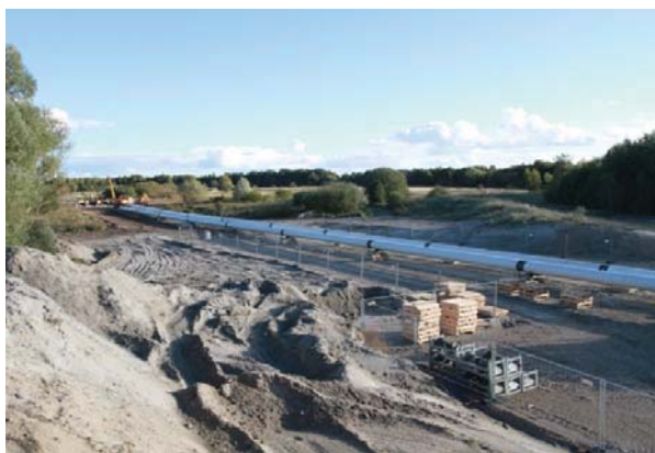
Dujotiekis: vaizdai iš statybų aikštelės
