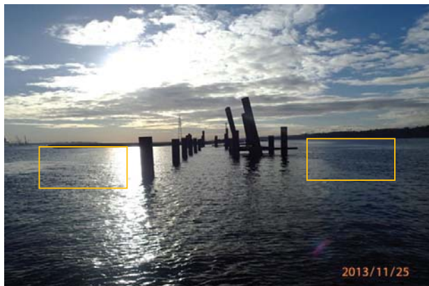
Krantinė: vaizdai iš statybų aikštelės
