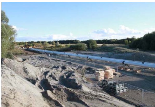
Dujotiekis: vaizdai iš statybų aikštelės
