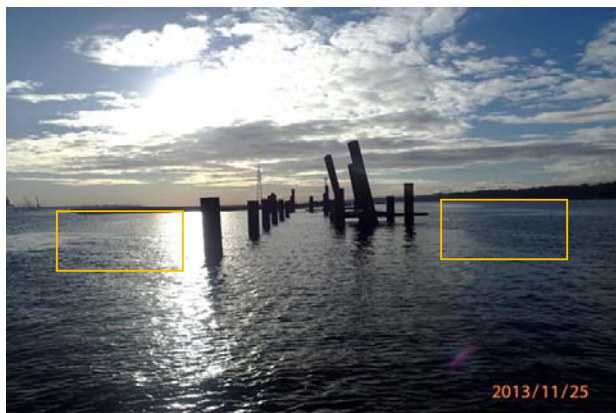
Krantinė: vaizdai iš statybų aikštelės
