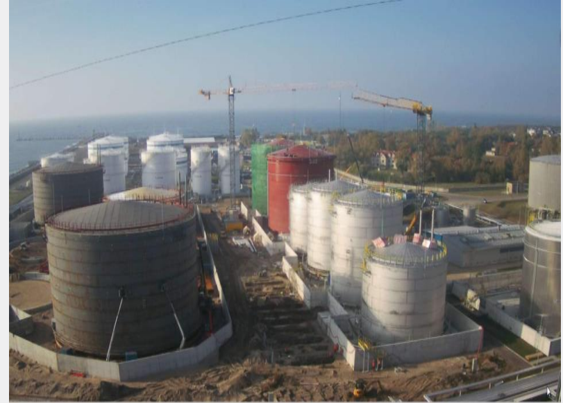
Šviesių naftos produktų 2 x 10 000 m 3 ir 4 x 5 000 m 3 rezervuarų parko statyba - šiuo metu vykdomi sienučių suvirinimo darbai, apsauginio gelžbetonio aptvaro, grindų bei lietaus nuotekų siurblinės betonavimo darbai.
