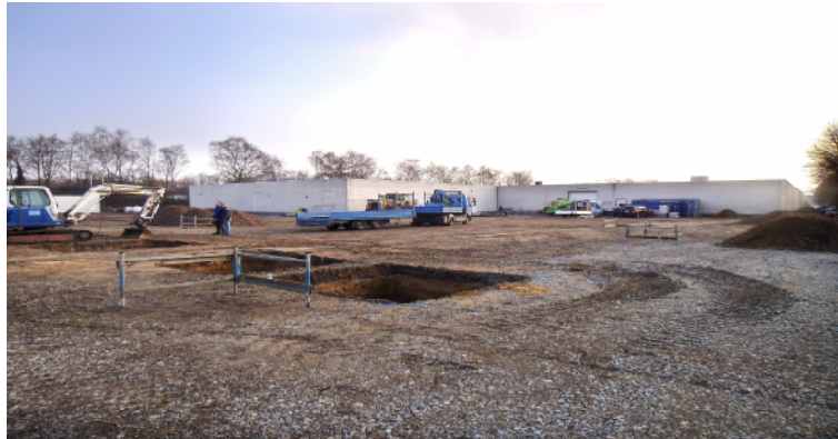
Baubeginn Neubau 1. April
