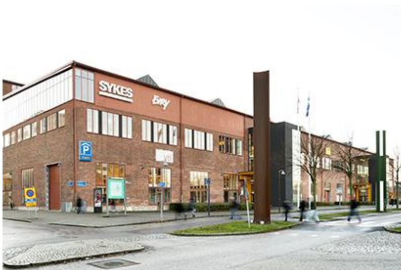
Fastigheten M2, Lindholmen, Göteborg. Foto: CBRE
