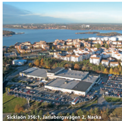
Sicklaön 356:1, Jarlabergsvägen 2, Nacka
