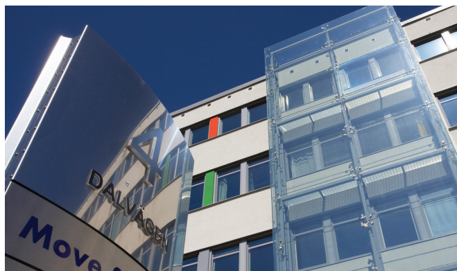
Renoveringen av fasaderna på fastigheterna Farao 16 och 17 i Arenastaden i Solna har avslutats under andra kvartalet. Efterfrågan på lokaler är god och hyresnivån ligger stabil runt 1 800 kr/kvm.
