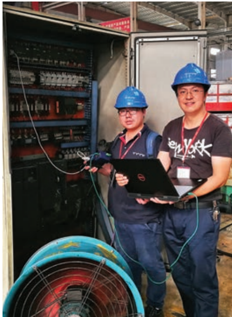
Installation av HMS produkter på fabrik i Kina.
