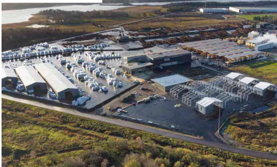
Impregneringsanläggningen vid Bravikens sågverk tas i drift under 2018.
