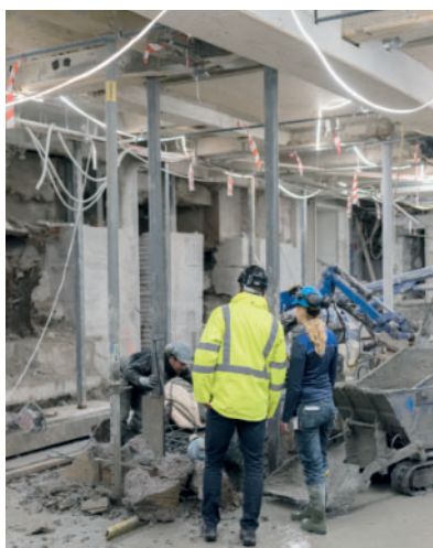
Grundförstärkningsarbete i NK-varuhuset Göteborg.
