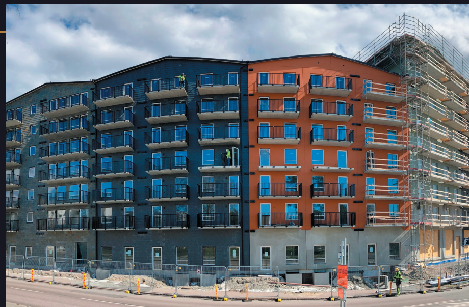
Vår nybyggnation av 103 Lamellhuslägenheter på Smörslottsgatan i Göteborg börjar ta form. Inflyttning december 2021.
