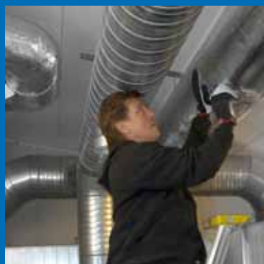
Monteringsarbetet effektiviseras och förenklas genom produktinnovationer och smarta hjälpmedel.
