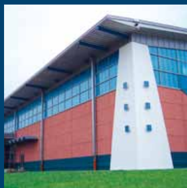
Färdig byggnad enligt kundens specifikationer står klar på kort tid. I detta fall en sporthall.
