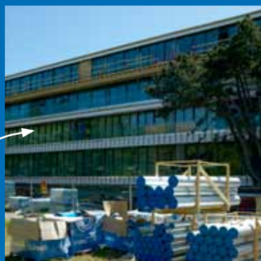
Just-in time leverans till byggarbetsplats.
