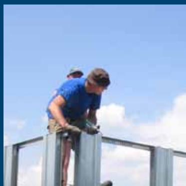
Delarna levereras färdiga att resas vilket minimerar behov av svetsning och kapning på byggarbetsplatsen.
