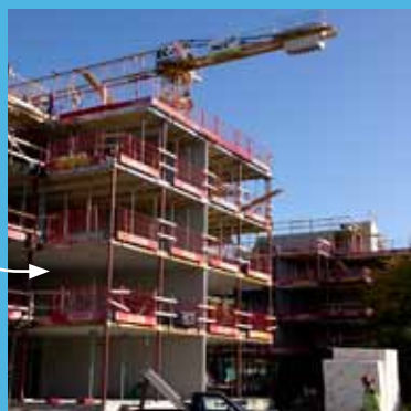
Leverans av färdigkapade, uppmärkta produkter till bygge av bostadshus.
