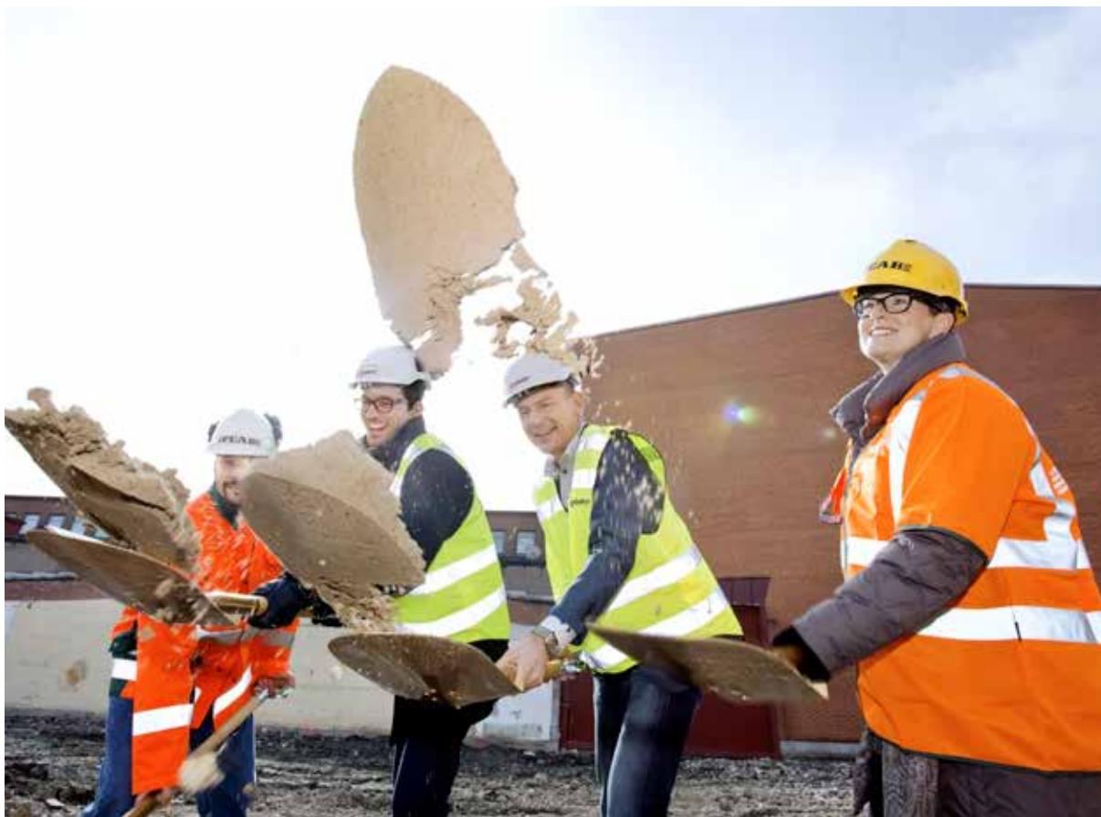
Den 14 mars 2014 togs första spadtaget i Platzers nybyggnadsprojekt Gårda 3:14.
