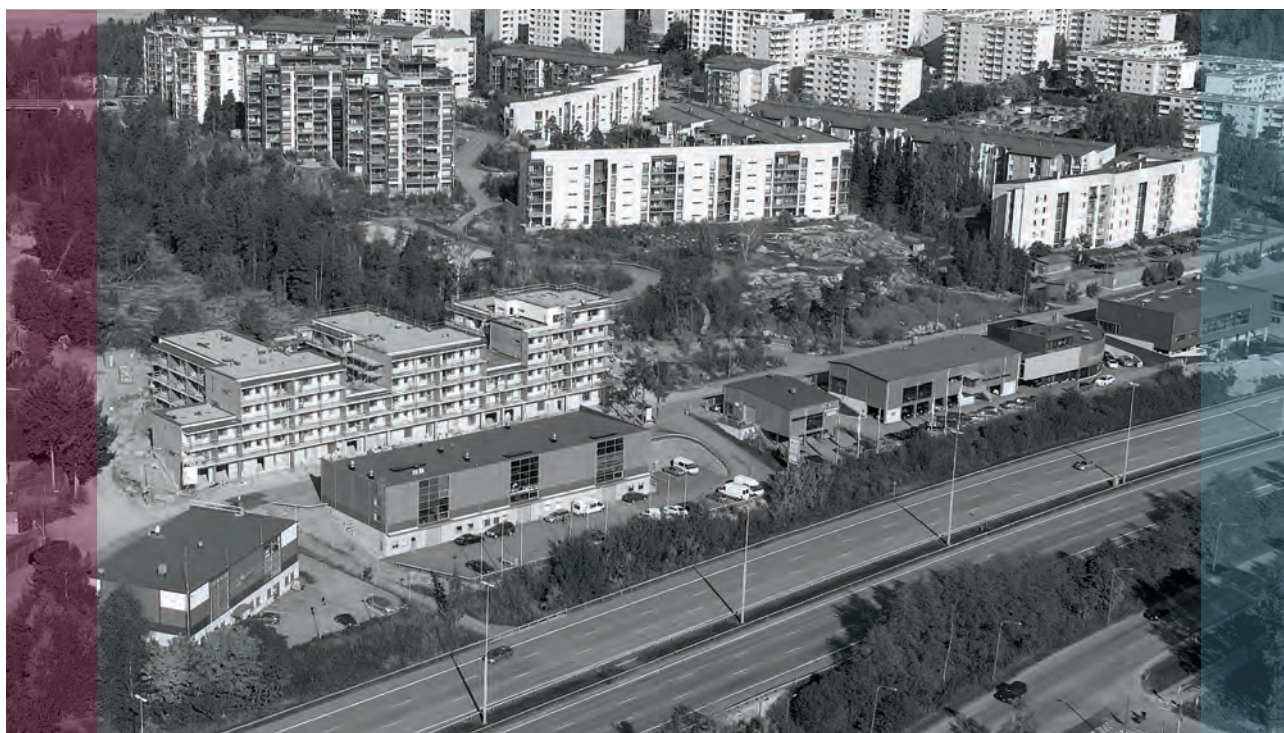
Hernepellontie 11 (91-36-66-1-L1) i Helsingfors, Finland, i bildens framkant, med 1 000 kvadratmeter uthyrningsbar area är belägen vid motorvägen till Lahtis intill en pågående bostadsproduktion.
