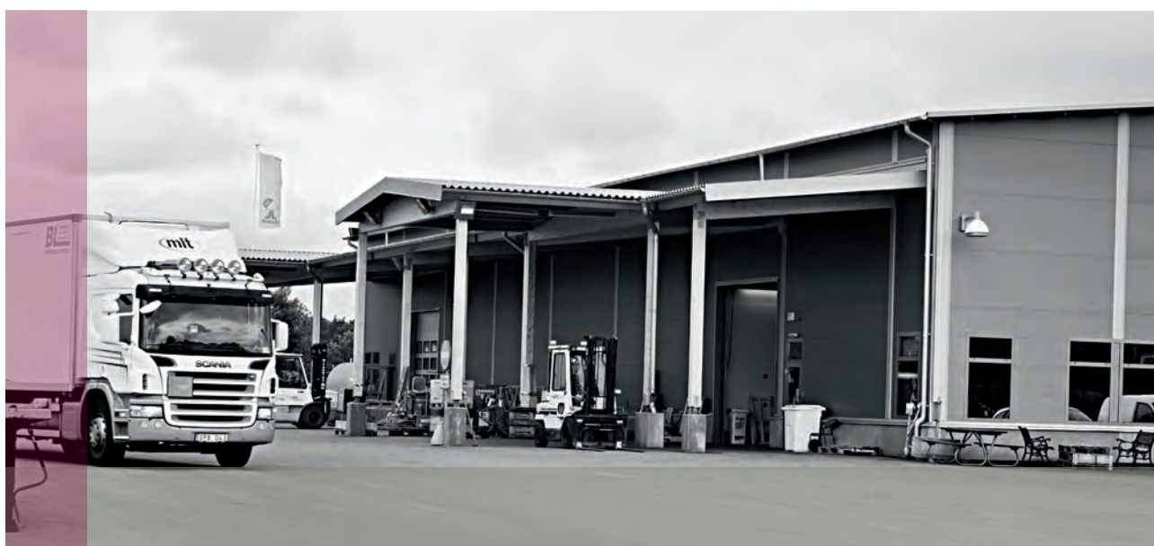
Veddesta 2:7 i Järfälla omfattar 5 100 kvadratmeter uthyrningsbar area och är i sin helhet uthyrd till maskinuthyrningsföretaget Ramirent.
