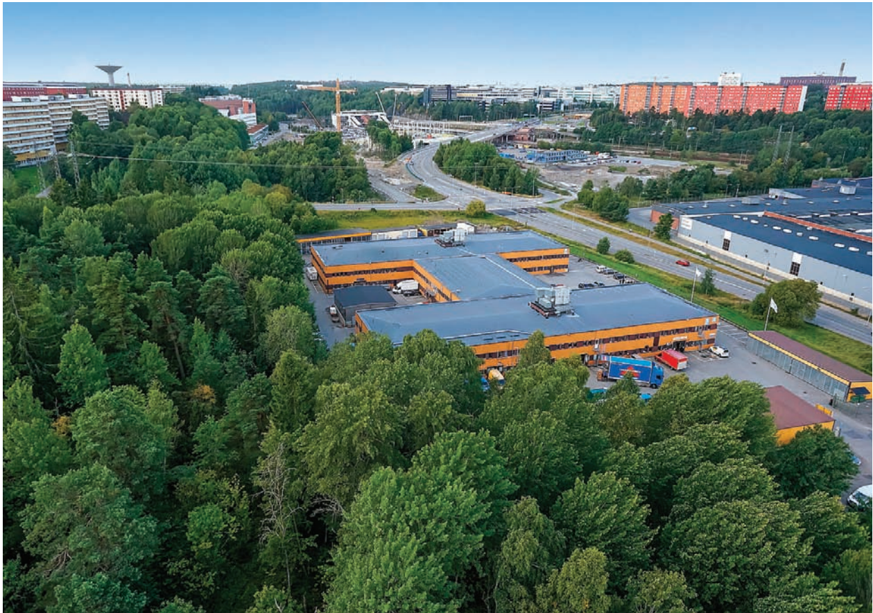
Akkumulatort 1 i Huddinge omfattar 9 300 kvadratmeter uthyrningsbar area samt 14 300 kvadratmeter friköpt markarea. Fastigheten är fullt uthyrd och ligger strategiskt belägen nära Flemingsbergs centrum med pendel- och fjärrtågsstation. Området är under snabb utveckling.
