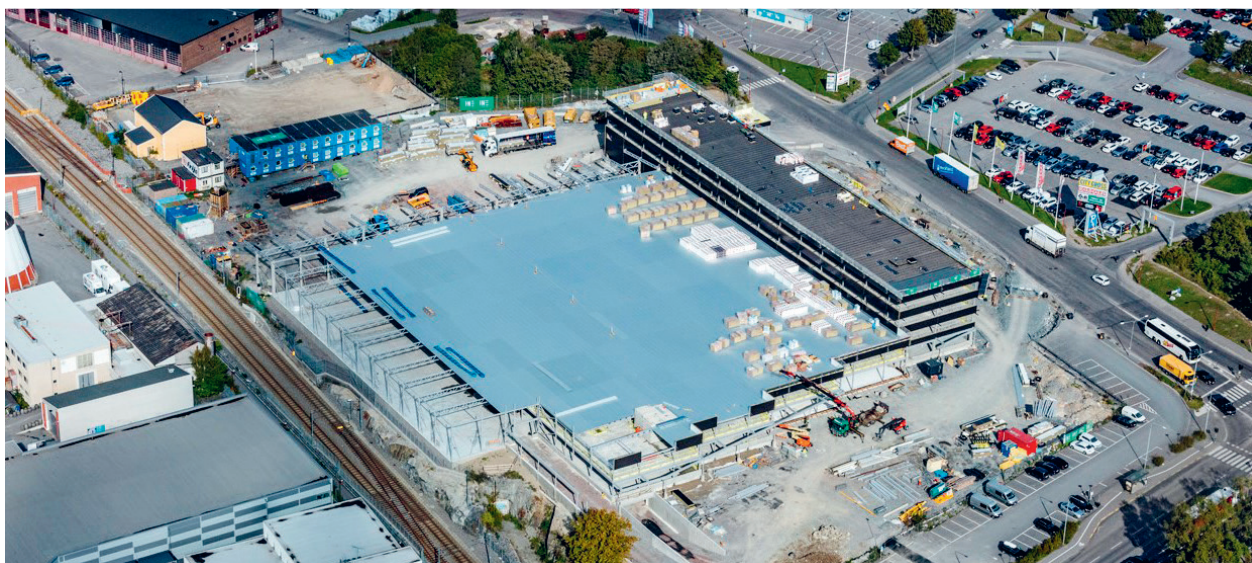
På Stockholm Gjutmästaren 8 i Ulvsunda industriområde i Bromma pågår nybyggnation av lager- och verksamhetslokaler om 19 000 kvadratmeter uthyrningsbar area. Lokalerna är fullt uthyrda. Byggnationen påbörjades under 2018 och färdigställande beräknas till inledningen av 2021.
