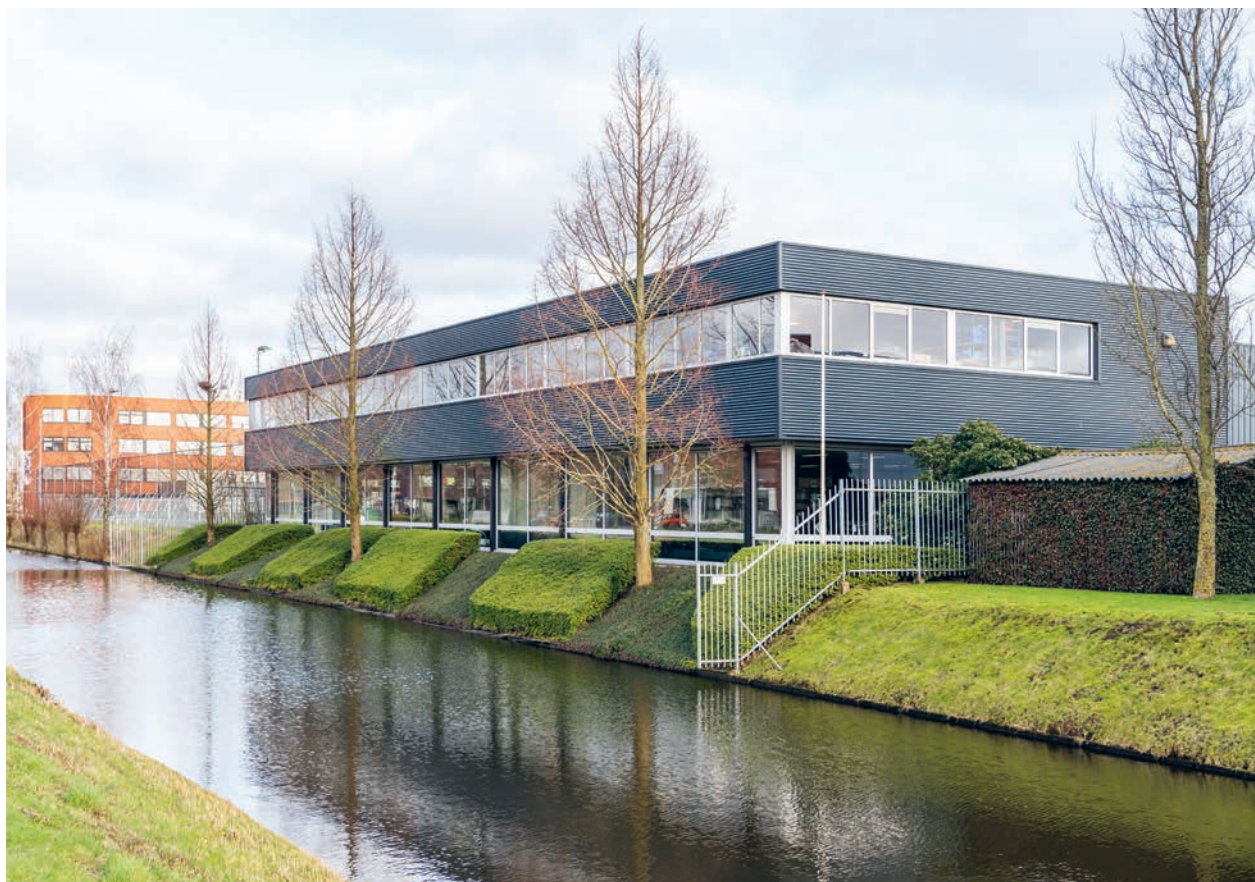
Under fjärde kvartalet 2019 förvärvades fastigheten Opaallaan 31 i Haarlem, 30 kilometer från centrala Amsterdam. Fastigheten omfattar 1 100 kvadratmeter uthyrningsbar area. Lokalerna är fullt uthyrda till en hyresgäst verksam inom hälsovård.
