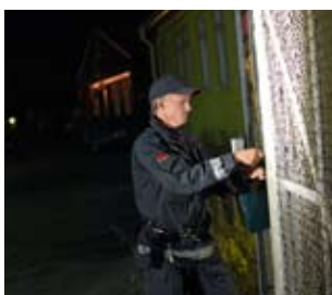
00.12 Brandinspektion på byggarbetsplats
