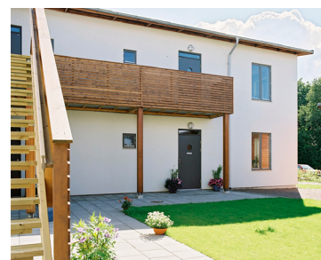
BoKlok, Helsingborg, Sweden.
