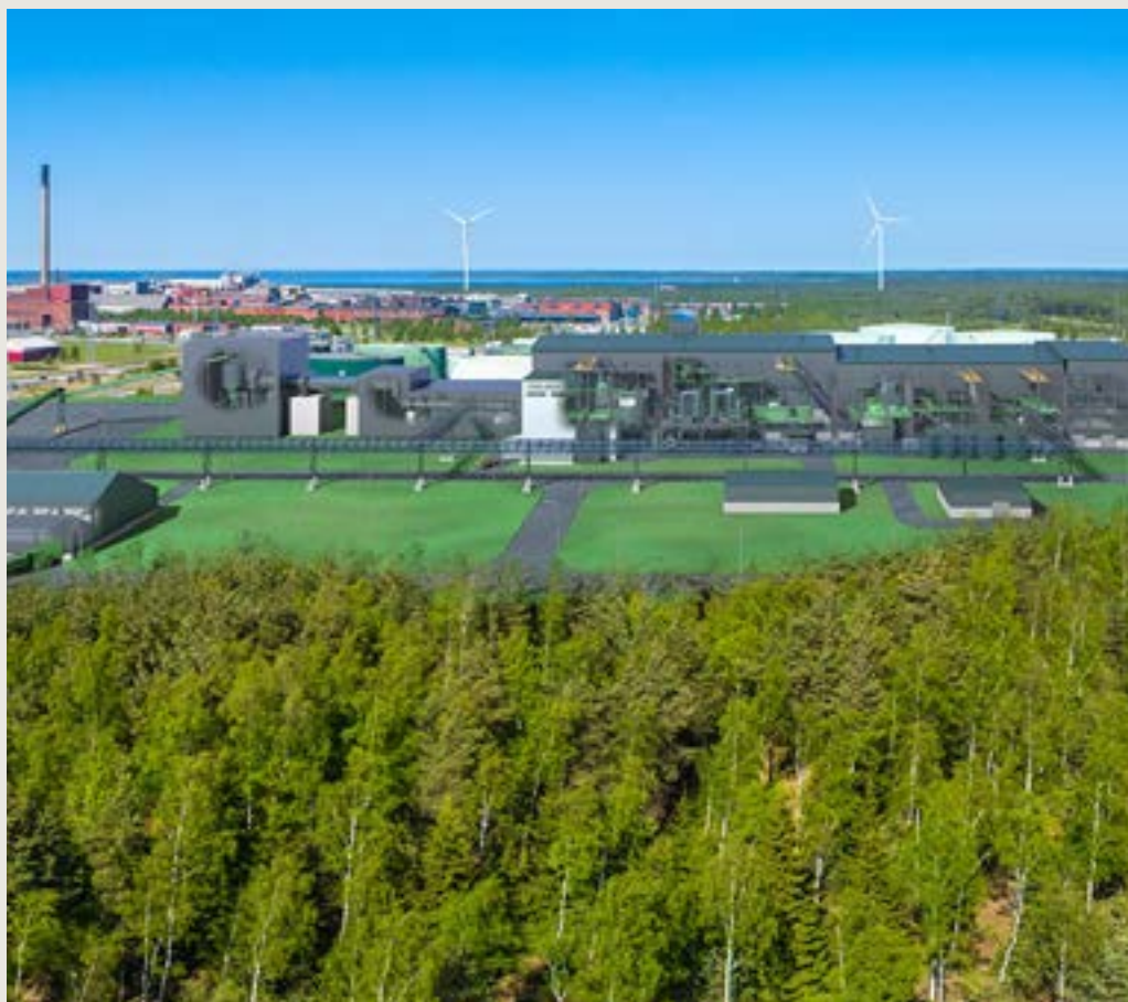
Storskaligt litium- batteriprojekt i Centrala Österbotten i Finland
