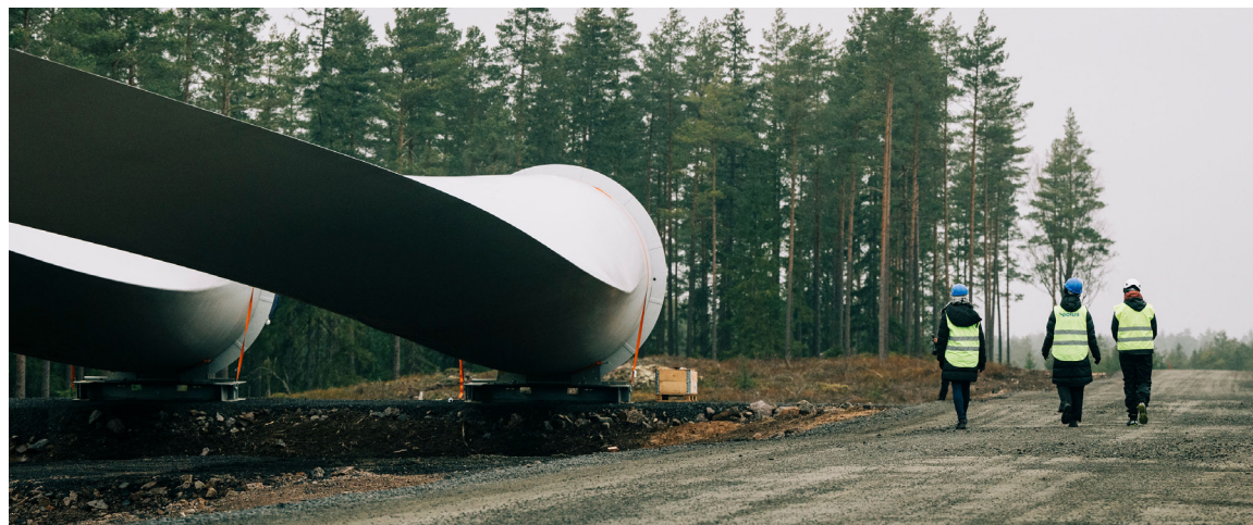
Turbinblad som väntar på montering i vindkraftspark Boarp som byggs i Vaggeryds kommun.
