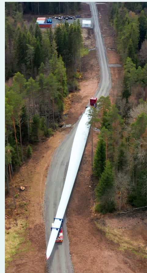
Eolus leder ofta byggnationen av projekt på uppdrag av ägaren. Bild från byggnationen av Rosenskog vindkraftspark i Falköping som byggdes 2023 för ägaren BKW.
