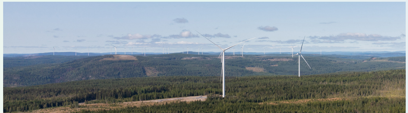
Eolus och Hydro Rein slutförde under första kvartalet byggnationen av vindkraftsprojektet Stor-Skälsjön med 260 MW installerad effekt.
