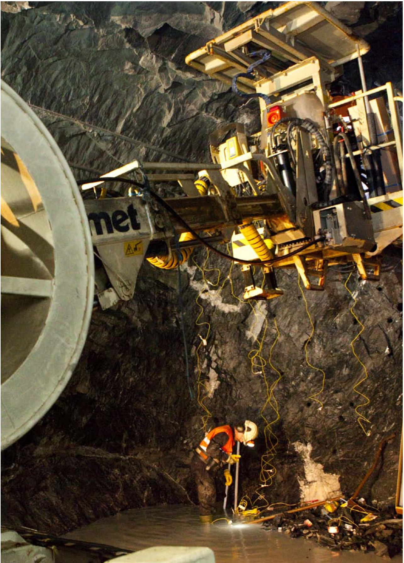
Förberedelse för sprängning i underjordsgruvan
