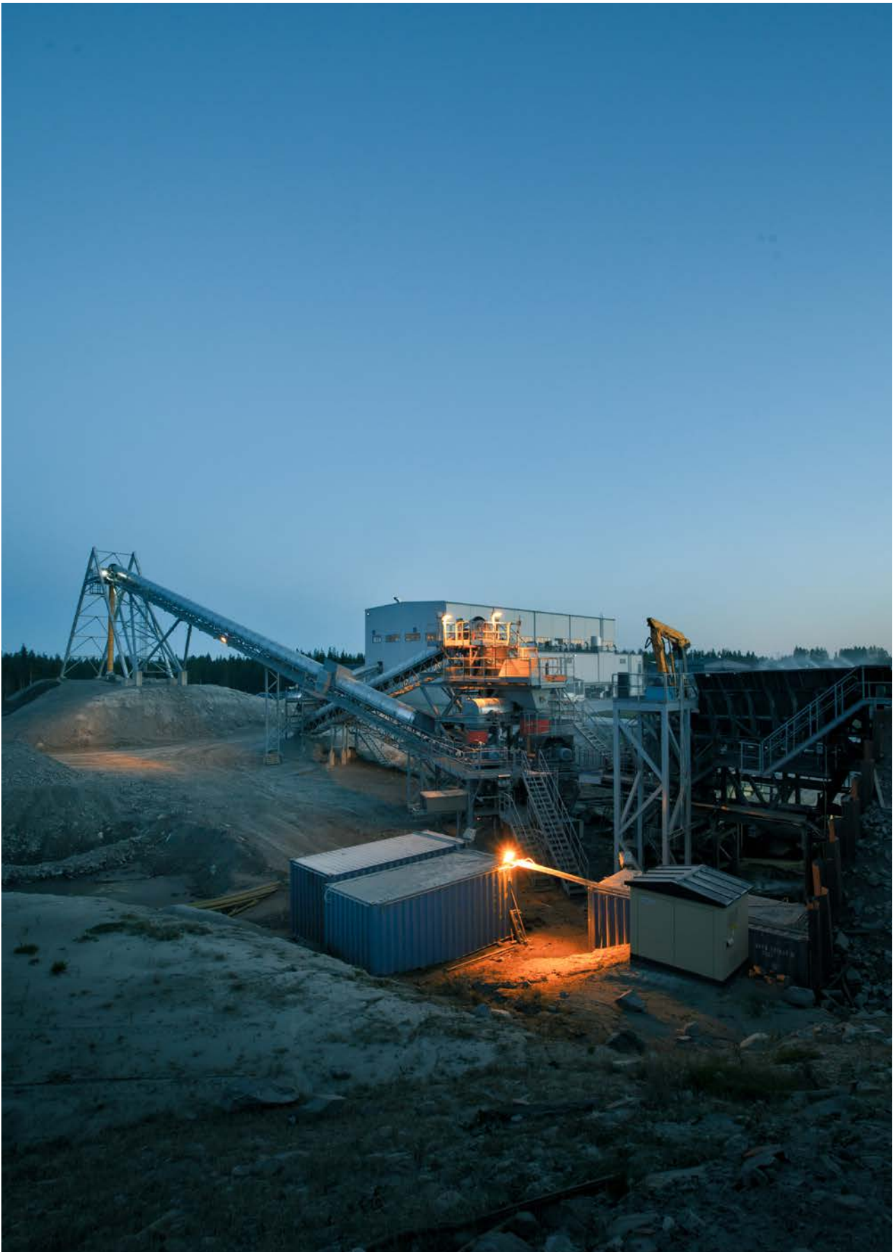
Kross och anriktningsverk i Pampalo
