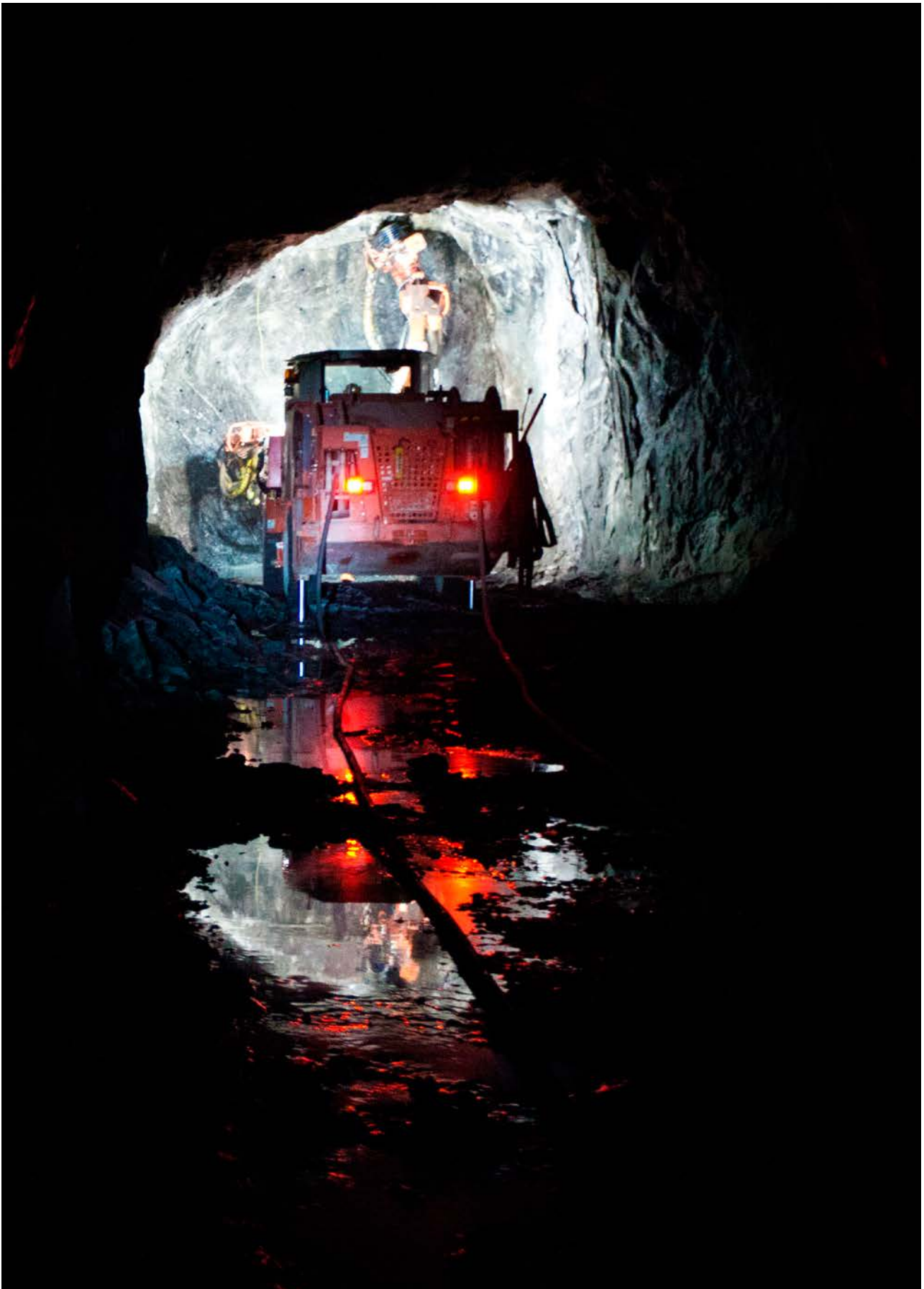
Ortdrivningsjumbo i Pampalo gruva
