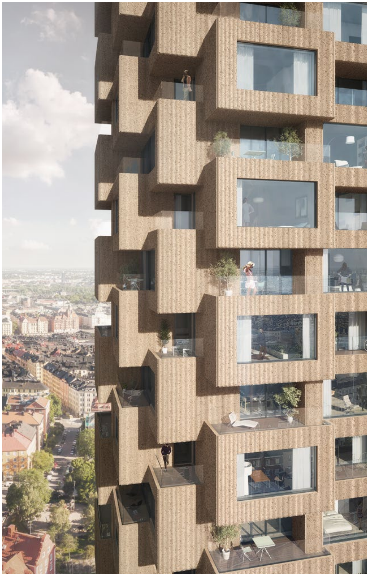
Under kvartalet påbörjades byggnationen av Helix, det andra av de två tornen i projektet Norra Tornen.
