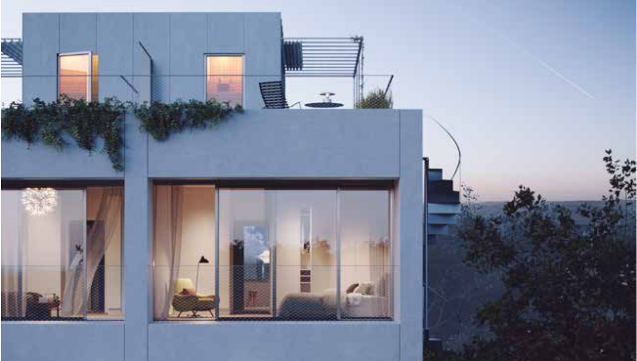
Unité, Norra Djurgårdsstaden.
