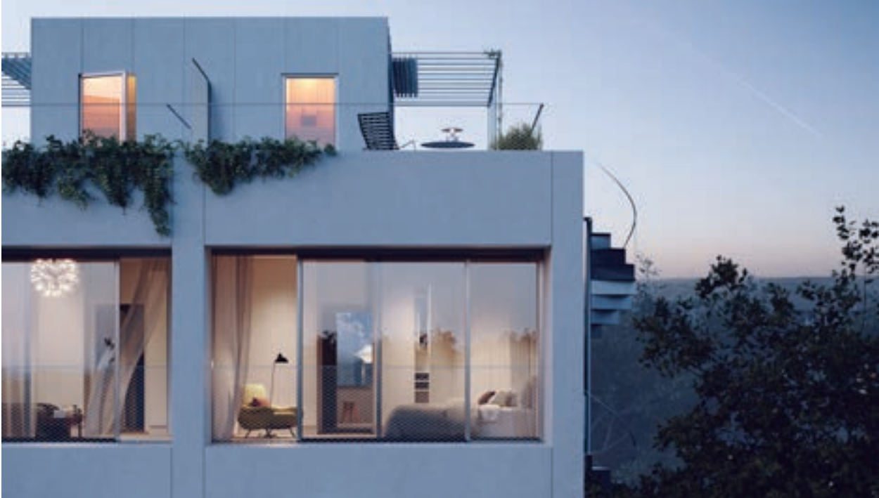
Unité, Norra Djurgårdsstaden.
