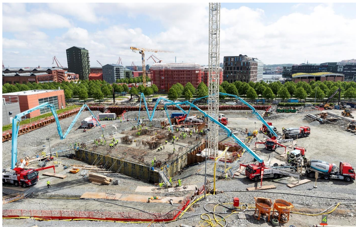
I maj genomförde Serneke gjutningen av Karlatornets bottenplatta, allt under loppet av ett dygn.
