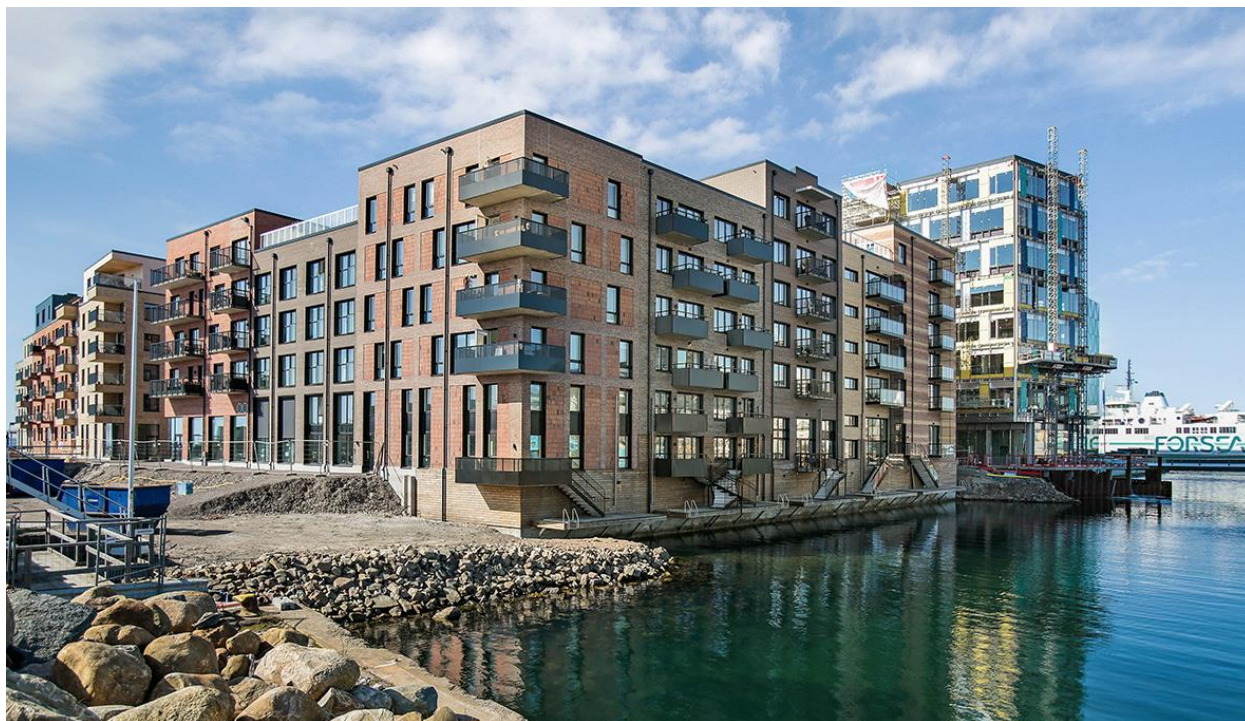
I mars 2021 slutförde Serneke byggnationen av bostadsprojektet Ophelias Brygga i Helsingborg, 124 lägenheter uppförda på uppdrag av Magnolia Bostad.
