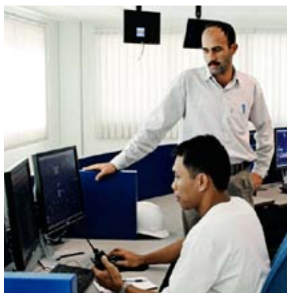
Et ECS kontrolcenter fra FLSmidth Automation. Et effektivt 24-timers kontrolcenter som er installeret på mere end 500 cementfabrikker verden over.
