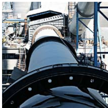
Montage af udstyr. Her cementmølleri med Filtax filtre samt cementovn.
