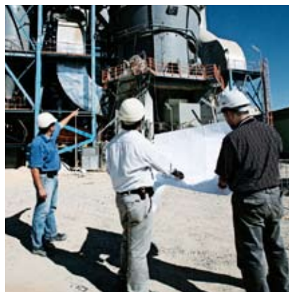
Byggepladsmøde på en ny FLSmidth cementfabrik i Mellemøsten. Her inspiceres pakkeriet og ATOX råmølleriet
