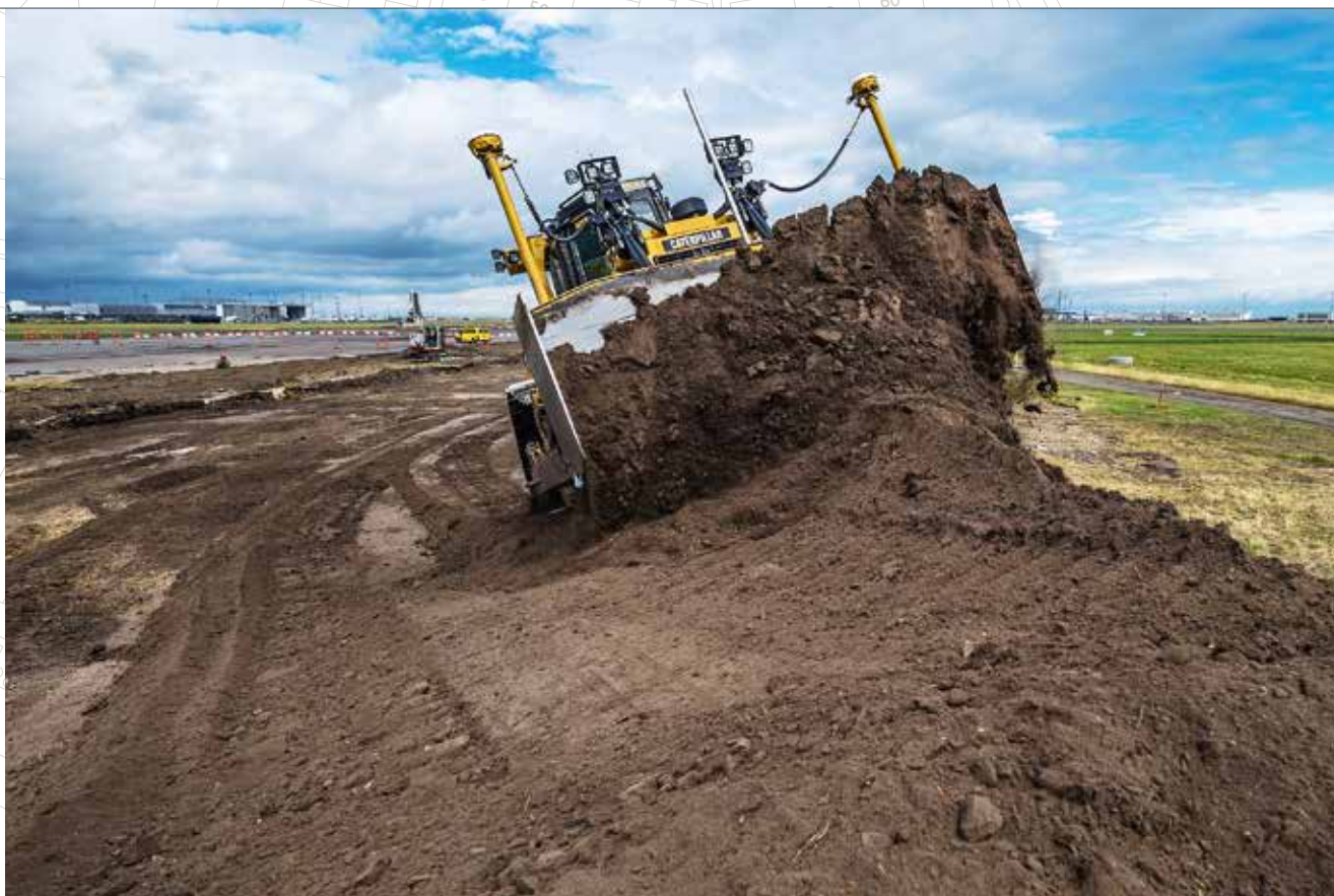
Aarsleff udvider landingsbane i Københavns Lufthavn med fire meter i hver side for at give plads til Airbus A380.
