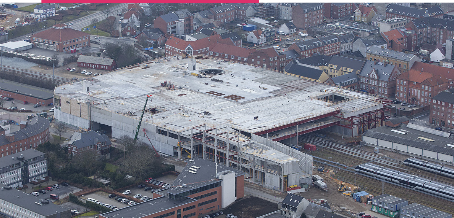
BROEN, shoppingcenter, Esbjerg, Danmark - forventet færdiggørelse i foråret 2017
