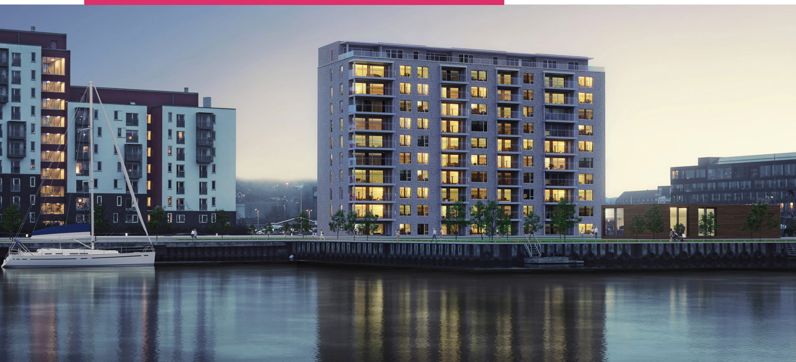
Ejerboliger, Beddingen, Østre Havn, Aalborg, Danmark - forventet byggestart medio 2017
