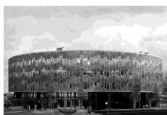
Opførelse skole Kalvebod Fælled Skole København
