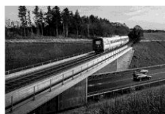
Opførelse og renovering 56 broer Banedanmark København-Rødby
