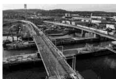
Opførelse bro i joint venture Marieholm Broen Göteborg
