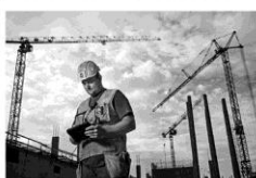
Opførelse råhus Nyt Aalborg Uni- versitetshospital Aalborg
